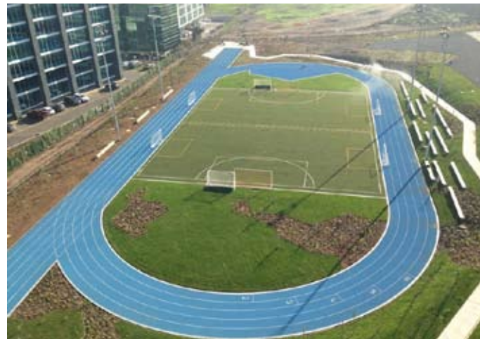
Diversas instalaciones en Chile atestiguan la calidad de los productos de esta empresa.
